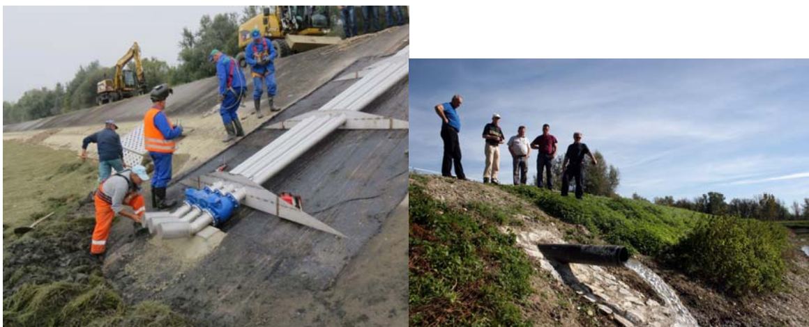
Slika 2: Izdelava odveznega dela cevovoda v bazenu Ormoškega jezera in prvi test cevovoda
