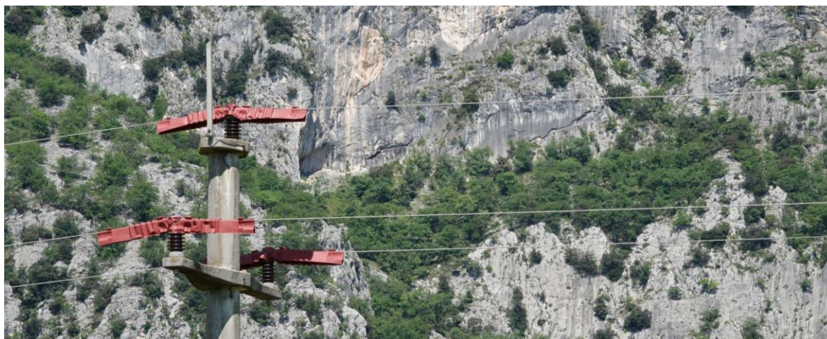
Slika 5: Izvedba sanacije s pomočjo izolacijskih kap. Foto: Tomaž Mihelič
