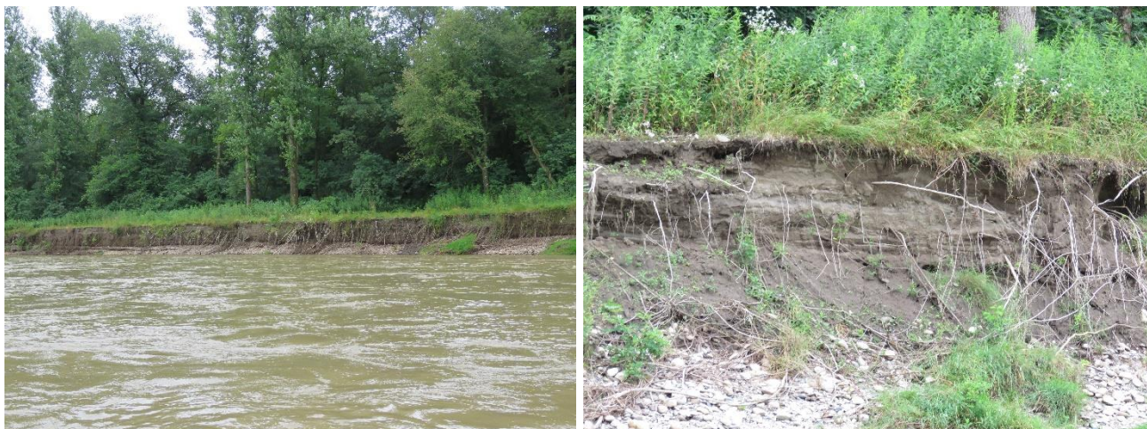
Slika 11: Strm breg Mure, vzpostavljen po naravni poti z bočno erozijo reke na odseku z odstranjenimi obrežnimi utrditvami (levo), v katerem se je nahajal aktiven gnezdilni rov vodomca Alcedo atthis (desno); lokacija Konjišče, 27. 6. 2024.
