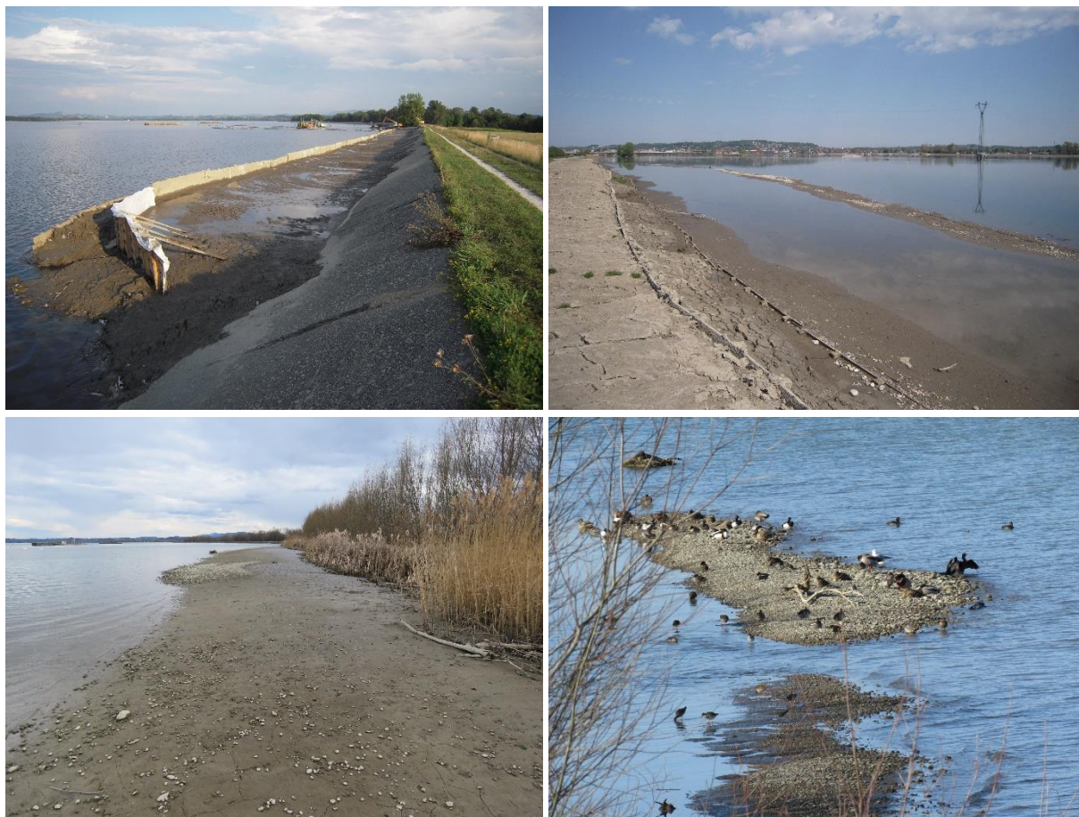
Slika 104: Oblikovanje sonaravne brežine na 200-metrskem odseku na Območju 5. Levo zgoraj: prva faza – prečrpavanje sedimenta v konstrukcijo iz muljnih zabojev (25. 7. 2014). Desno zgoraj: druga faza – oblikovanje položne notranje brežine do zaključka s prodnim nasipom (23. 4. 2015). Levo spodaj: pogled na obsežno obrežno plitvino z gorvodnega konca ob nižji gladini jezera; na zunanem robu je opazno zaraščanje trstišča (14. 3. 2019).
