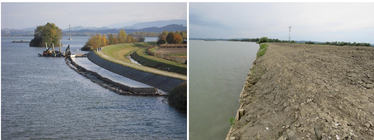
Slika 105: Oblikovanje novih brežin na Območju 5 (ostalo). Levo: Postavljanje lesene konstrukcije muljnih zabojev (21. 10. 2011). Desno: nova brežina na odseku med Velikim otokom in ornitološko opazovalnico strmo prehaja neposredno v vodo na območju poglobljenega dna (27. 6. 2018). Str. 42 levo: Isti odsek po umetni zatravitvi nove brežine; vidni so začetki zaraščanja z lesno vegetacijo vzdolž notranjega roba (5. 9. 2018). Str 42 desno: Pas visoke in goste lesne vegetacije vzdolž notranjega nove brežine – obstoječe stanje (6. 6. 2024).
