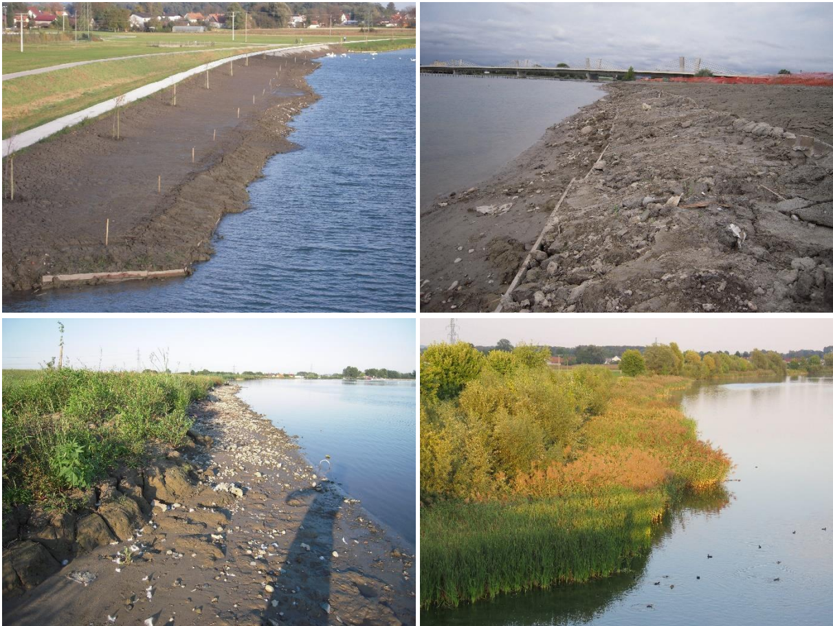
Slika 101: Prekrivanje asfaltnega nasipa z muljnimi zaboji na Območju 1. Levo zgoraj: pogled s Puhovega mosta na gorvodni del območja med izvedbo, pri kateri je bila oblikovana položna brežina (21. 10. 2011). Desno zgoraj:
